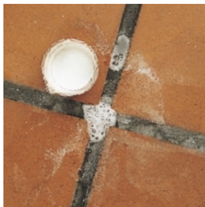
Limpeza das eflorescências
