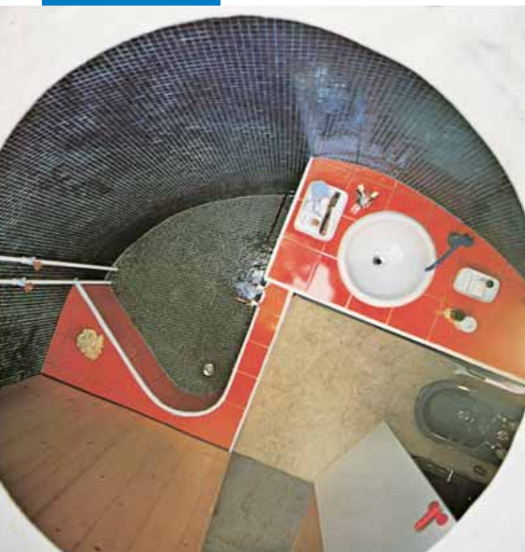
Realização de lavatório e duche impermeáveis
