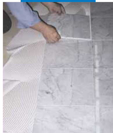
Assentamento de mármore de Carrara sobre suporte em madeira com Keralastic branco
