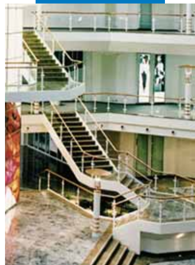
Exemplo de assentamento de revestimentos em cerâmica ou mármore sobre uma estrutura em metal (escada)
