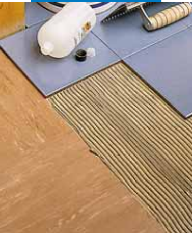
Assentamento sobre pavimento velho em PVC
