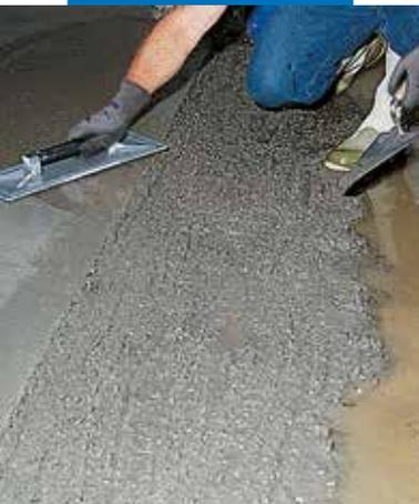
Aplicação da betonilha aditivada com Idrosilex Liquido
