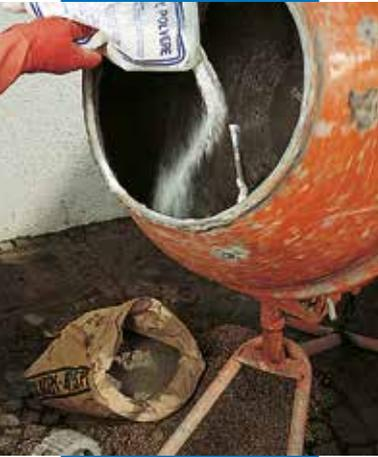
Preparação da argamassa hidrófuga aditivada com Idrosilex Polvere
