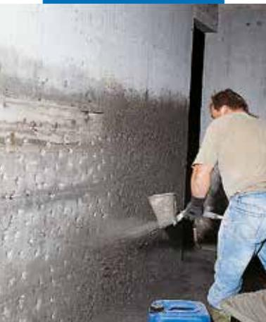
Aplicação com pulverizador de copo da 1ª camada de argamassa aditivada com Idrosilex Liquido
