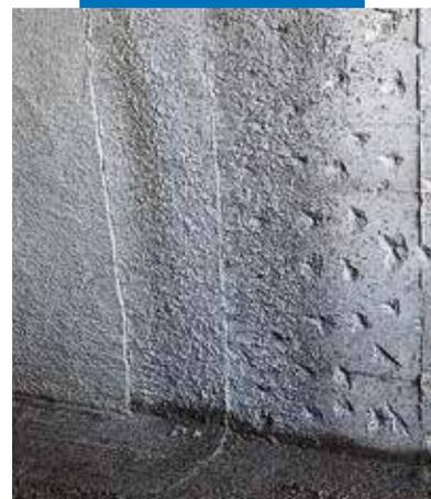
*Aplicação de argamassa de reboco aditivado com Idrosilex sobre betão rugoso*
