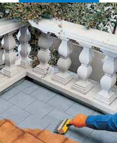
Aplicação de Primer para Aquaflex
