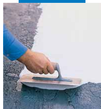
Aplicação sucessiva com espátula do Aquaflex
