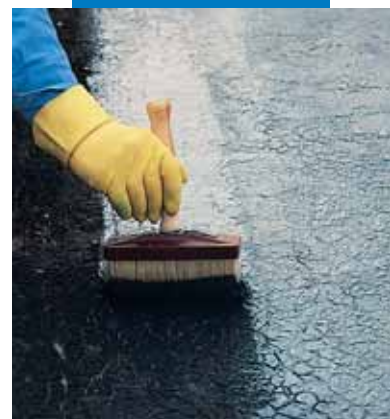
Aplicação do Aquaflex sobre membrana asfáltica velha
