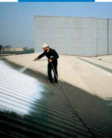
Aplicação do Aquaflex por projecção sobre cimento-amianto ondulado tratado com Primer para Aquaflex
