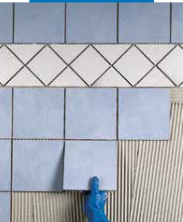
Assentamento de monocozedura em parede sobre reboco
