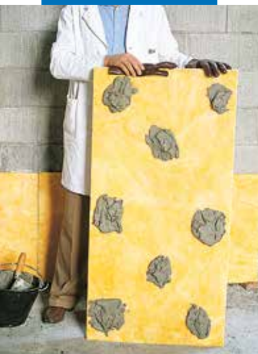
Colagem por pontos de painéis de isolamento
