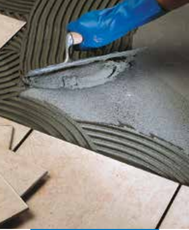
Assentamento de monocozedura em pavimento
