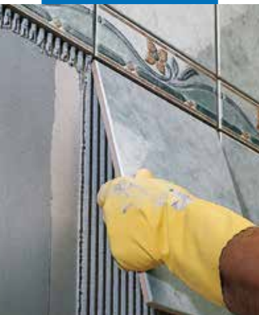
Assentamento de monocozedura em parede gesso cartonado
